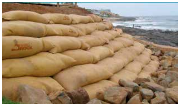
Large-format geotextile bags (EnviroRock R).
