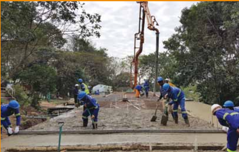
Foxcrete 36m Nduna slab
